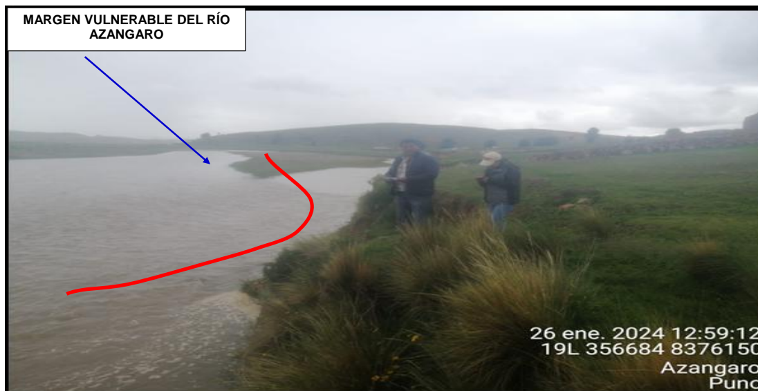
FIGURA N°02: LA PRINCIPAL VIA EXISTENTE Y PROPENSAS ANTE UNA CRECIDA DEL RÍO AZANGARO Y LA EROSION EN LA MARGEN IZQUIERDA
